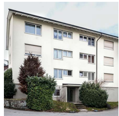
69. Richterswil ZH, Zugerstrasse 28-36
