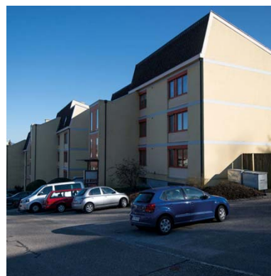
36. Laufen BL, Grienweg 3/5/7
