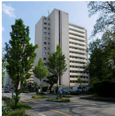
77. Spreitenbach ZH, Bahnhofstrasse 61
