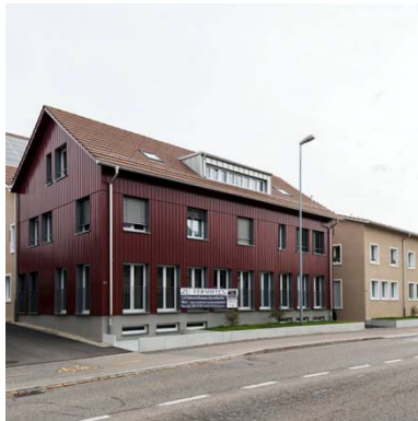
61. Pfäffikon ZH, Hochstrasse 137/139/141, Langackerstrasse 8/10
