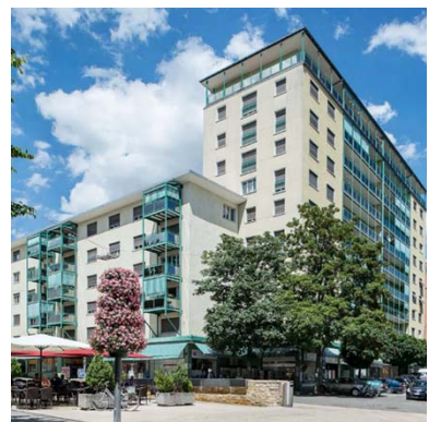
33. Grenchen SO, Marktstrasse 1/3, Marktplatz 14/16
