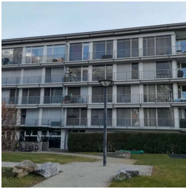
22. Chur GR, Ringstrasse 205, Saluferstrasse 12
