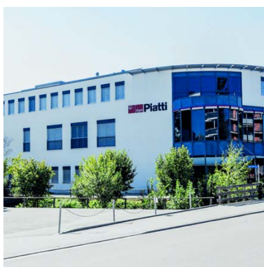
91. Dietlikon ZH, Riedmühlestrasse 12/16/18
