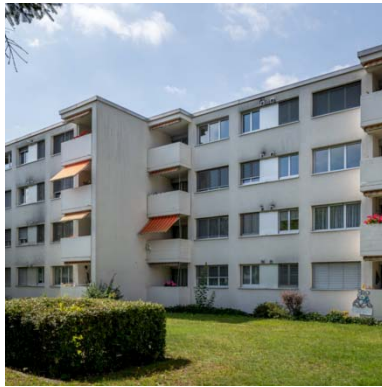
58. Oftringen AG, Staufergutstrasse 2/4
